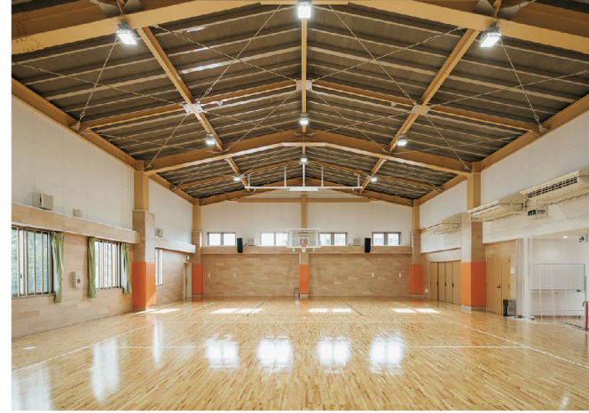
屋内運動施設(4F) [冷暖房完備]
